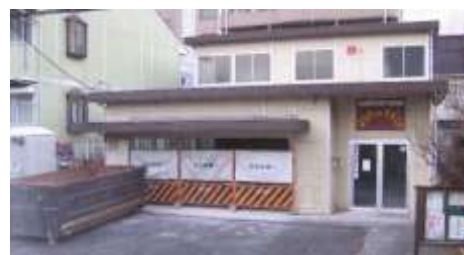
2012/01/14 解体が始まる
